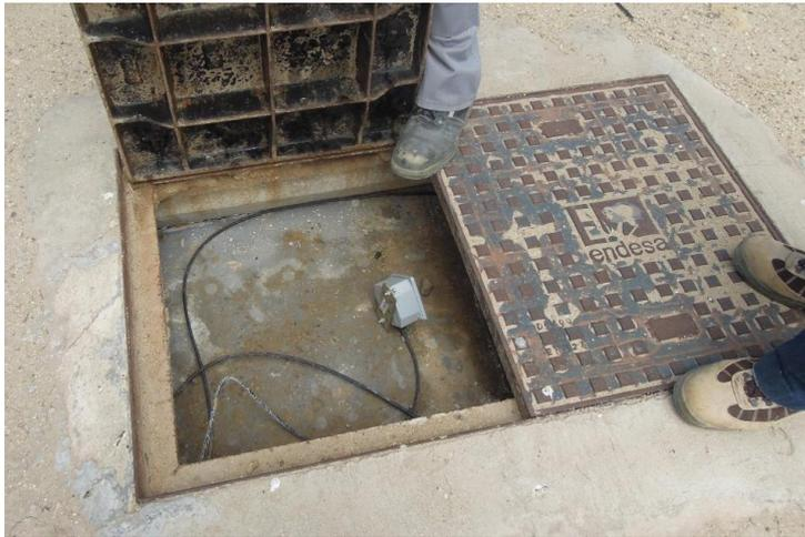
Meilleure protection contre les vols de cuivre: Les puits sont remplis de sable, scellés par une couche de béton et dotés d'un capteur supplémentaire.
